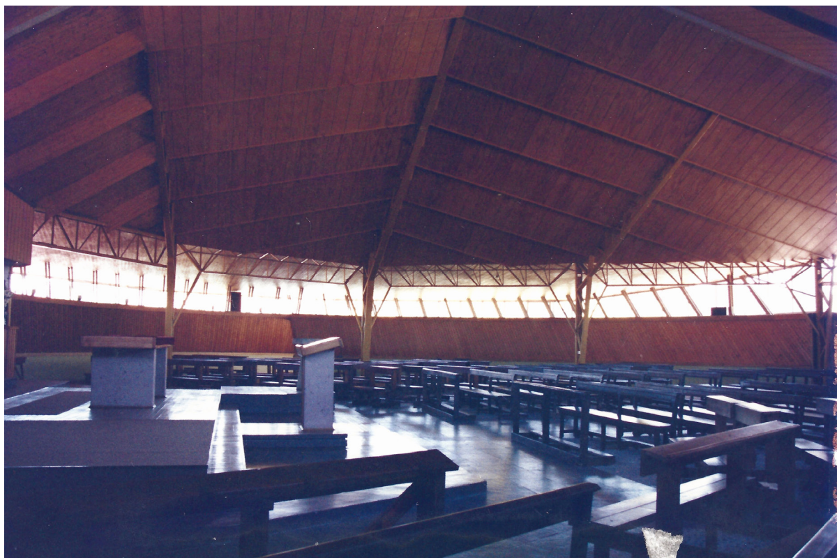
Fig_004 Iglesia Parroquial de Arauco, Chile. Por la autora. Obsérvese el tratamiento de la luz, que accede perimetralmente. Para ello, se desarrolla un ventanal perimetral de aprox. 50 cm, al cual se le anteponen piezas diagonales de madera, que en conjunto aportan un juego de luz y sombras.
